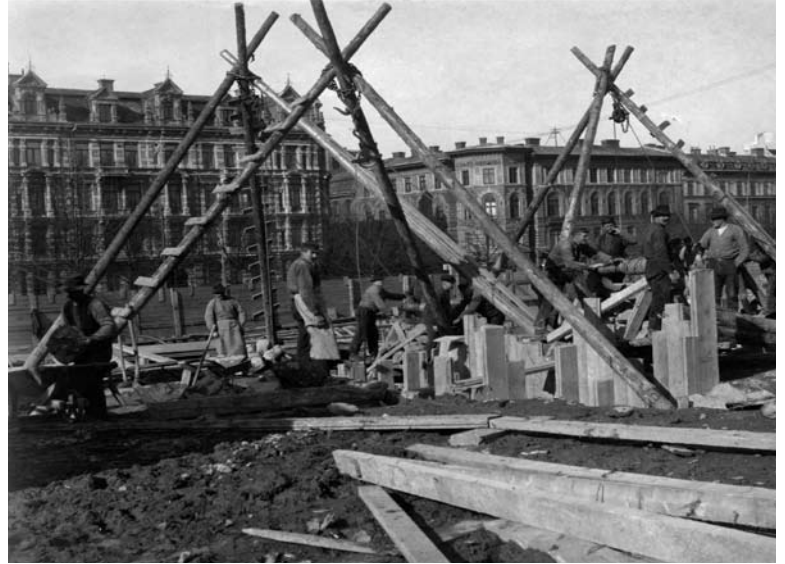
Byggnadsarbetare lägger grunderna till den nya högskolan.
